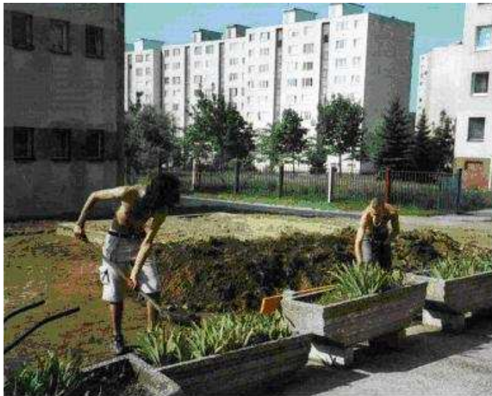
Odstraňovanie starého podlažia ručne.
